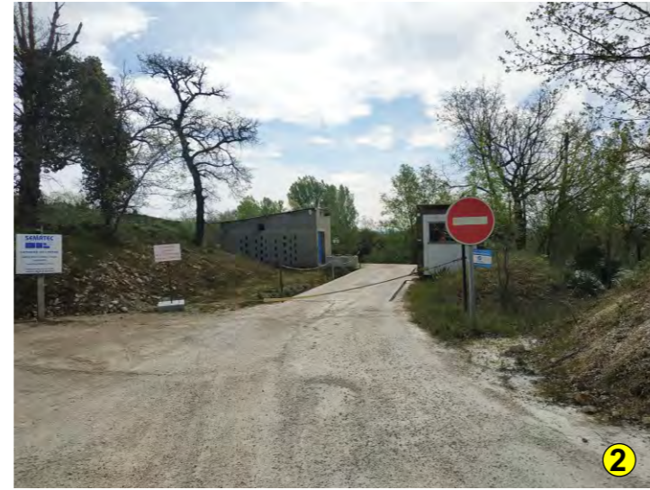
Sortie du site - bascule et local
